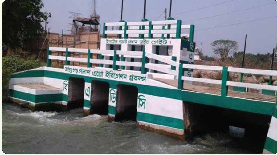
ব্রাহ্মণবাড়িয়া জেলার আশুগঞ্জ পাওয়ার স্টেশনের ইনটেক পয়েন্টে নির্মিত স্লুইস গেট
