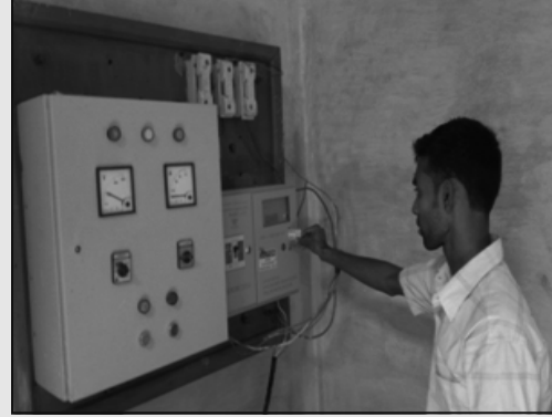
সেচ চার্জ আদায়ে থ্রিপেইড মিটারের ব্যবহার
