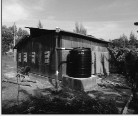
আইএপিপি প্রকল্পের আওতায় বৃষ্টির পানি সংরক্ষণাগার
