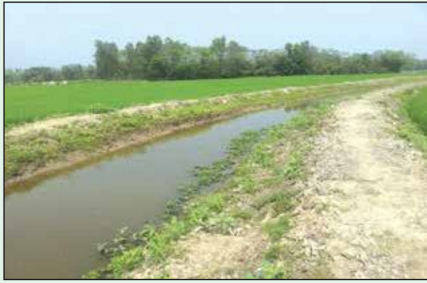
কুমিল্লা জেলার মনোহরগঞ্জ উপজেলার খাল পুনঃখনন কার্যক্রম
