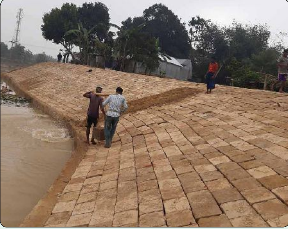
শেরপুর জেলায় মেঘাবাদী রাসার ডায়মের সিসি চুক ও গাইড ওয়াল নির্মাণ
