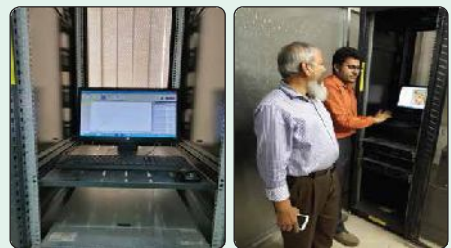
ডাটা লগারের মাধ্যমে কুর্ভর্স পানির স্তর ও গলণাক্ততা পর্যবেক্ষণের জন্য স্থাপিত সেন্সার সার্কিট
