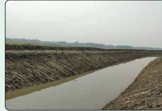
নেরাকোনা জেলার কলমাকান্দা উপজেলায় বিকুলজার খাল খনন/পুনঃখনন কার্যক্রম
