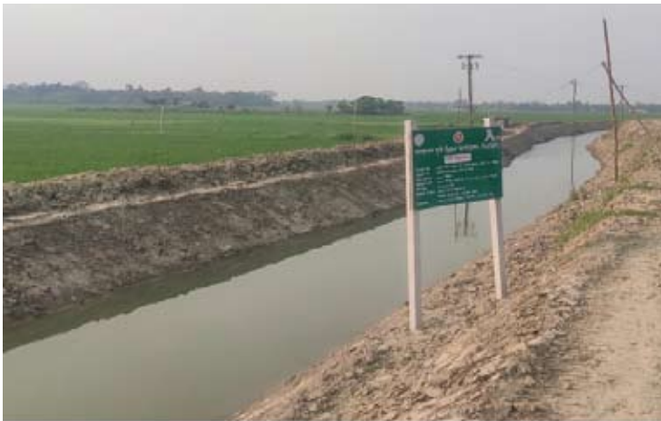
ঢাকার নবাবগঞ্জে নবগ্রাম খাল পুনঃখনন
